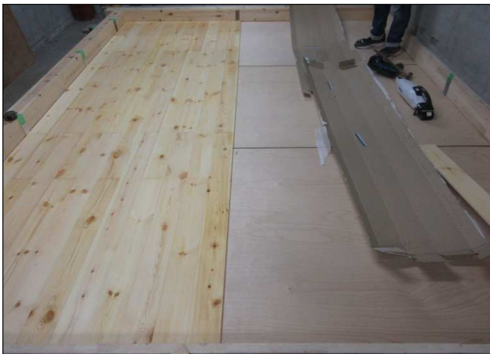
(d) Layout of the solid wood floorings
