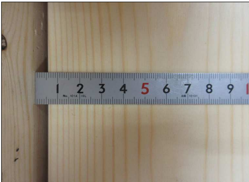
(d) Clearance of solid wood floorings
