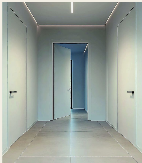
門片、隔間 (走廊暗門)
